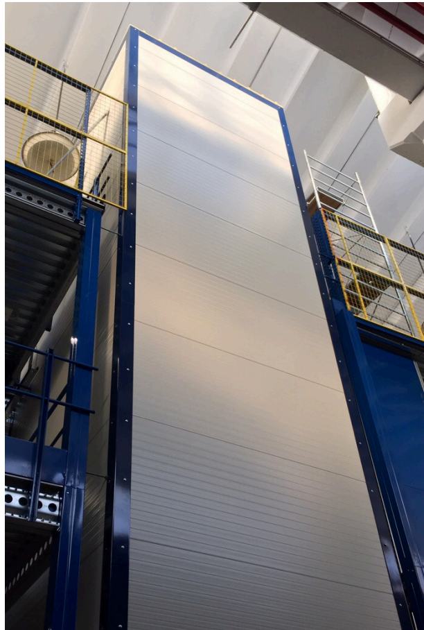
STRUTTURA R3 TLC PER ESTERNI - COIBENTATA Installata in area produttiva. Tamponamento con pannelli coibentati e finiture in lamiera verniciata Ral a polveri.
