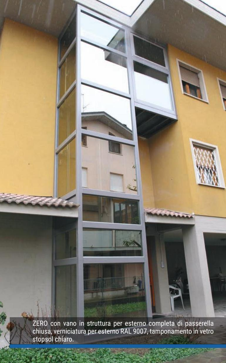
ZERO con vano in struttura per esterno completa di passerella chiusa, verniciatura per esterno RAL 9007, tamponamento in vetro stopsol chiaro.
